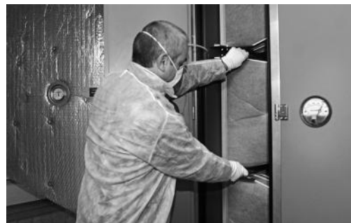
Les filtres doivent être régulièrement remplacés.
