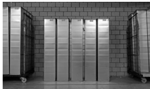
Gaines d'air avant leur installation, entreposées de manière propre et ordonnée.
