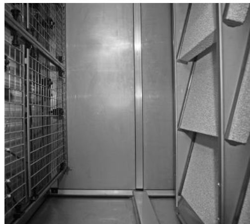
Vue d'un déshumidificateur hybride: l'état hygiénique doit être régulièrement vérifié.
