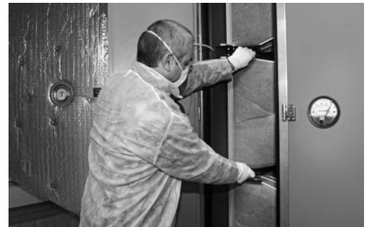
Filter müssen regelmässig gewechselt werden.
